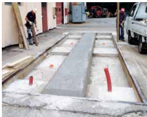
Esempio di recupero di una fossa pre-esistente
