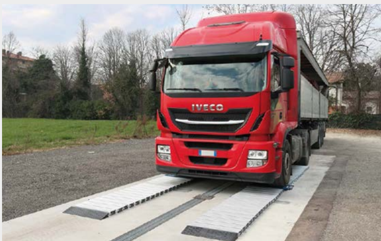
Instalación con módulos de nivelación.
